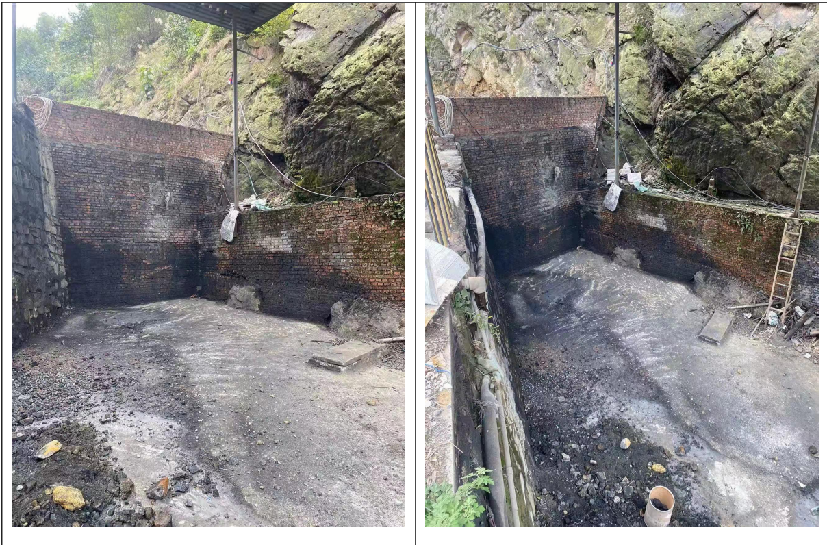
原储煤场、渣场恢复照片
